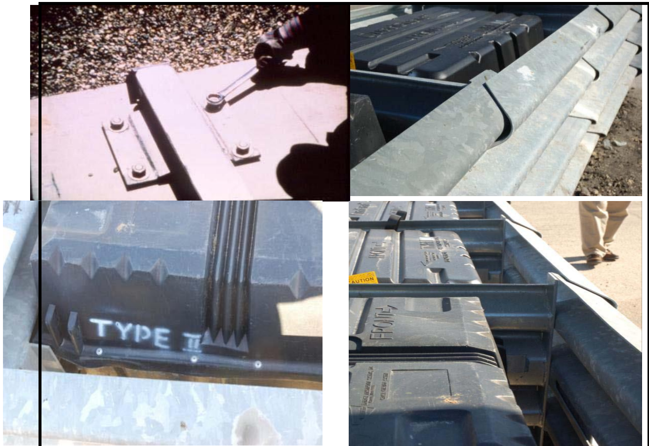
شکل ۱۶ - جزئیات ضربه‌گیر Quadguard
