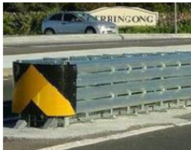
شکل ۲۸ - جزئیات اجرایی ضربه‌گیر هدایت کننده (از نوع تائو ۲) برای سرعت ۱۱۰ کیلومتر به ساعت
